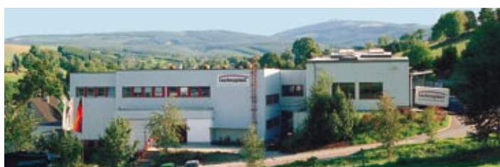
Fábrica de Neudorf / Alemanha
