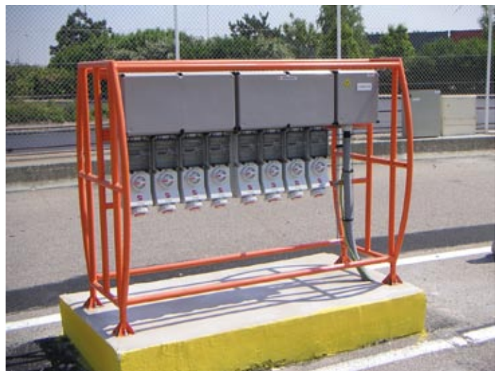
Terminal de Contentores, Le Havre – França
